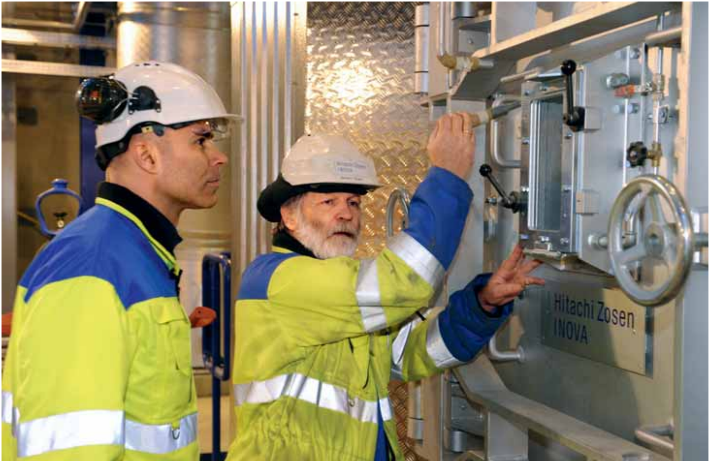
Mit Abfall zur Energiegewinnung: Die Anlage in Vaasa (Finnland) wurde von 2010 bis 2012 gebaut. Sie produziert durchschnittlich 13 Megawatt elektrische Energie und 40 Megawatt Fernwärme aus einer Jahresleistung von 150'000 Tonnen Siedlungs- und Gewerbeabfall und versorgt damit mehr als 30'000 Haushalte mit Strom und Wärme.
